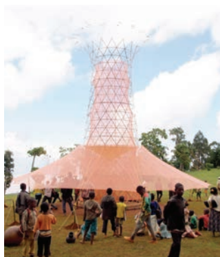
برج Warka Water 3.2
