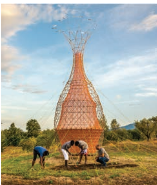
برج Warka Water 1.9
