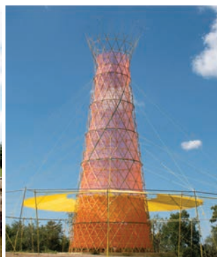
برج Warka Water 3.7
