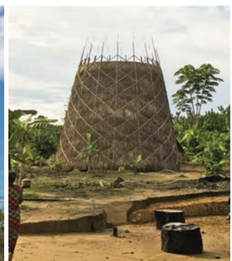
برج Warka Water 4.1
